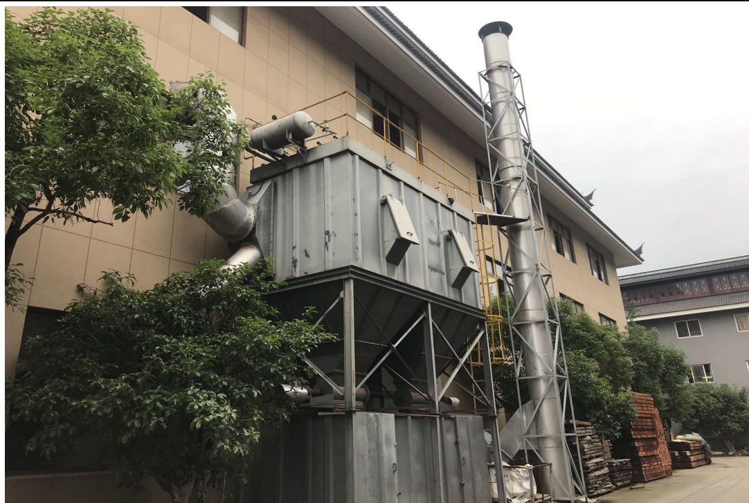
图4-5 木工车间废气处理设施
