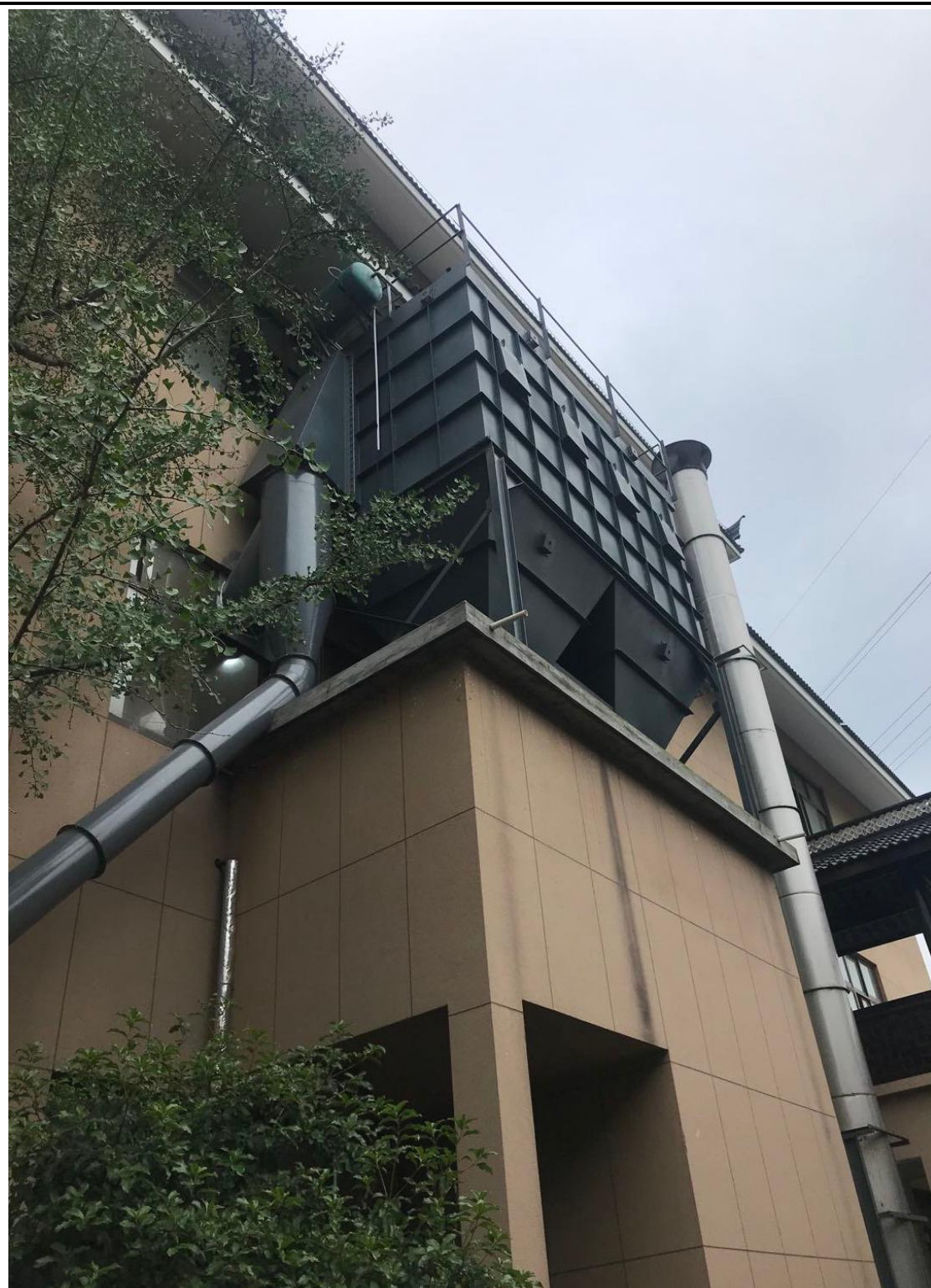
图4-7 木工、配料车间废气处理设施
