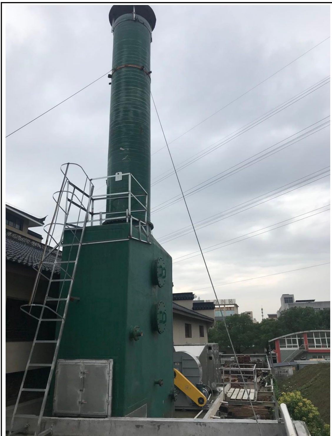
图4-14 油性漆废气处理设施
