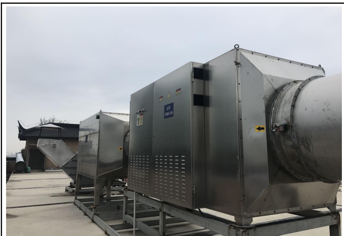
图4-13 水性漆废气处理设施
